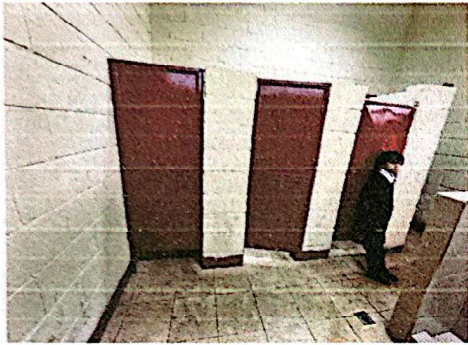
Foto 7: Mantenimiento a puertas de baños.
