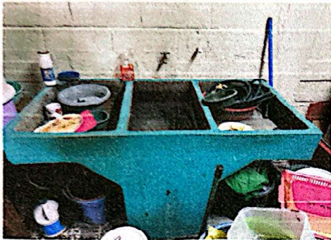
Foto 1: Suministro e instalación de pila.
