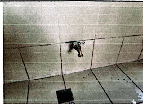
Foto 6: Suministro e instalación de chorros
