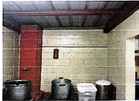
Foto 2: Aplicación de pintura en muros internos de cocina.
