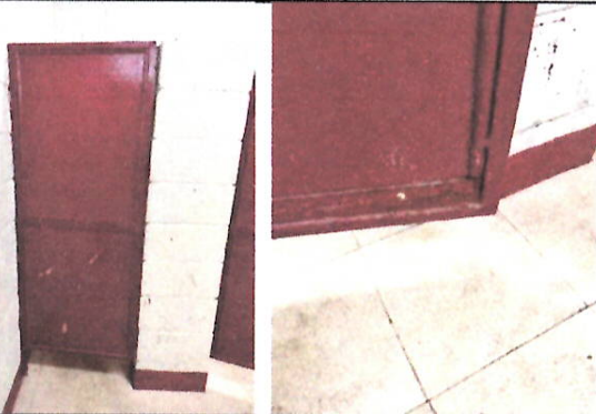
Foto 9: Las puertas de los baños están con problemas de oxido, por lo que se les debe dar mantenimiento.
