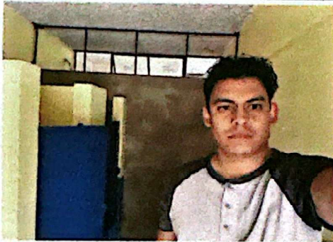
Foto 9: Muros divisorio en baños.
