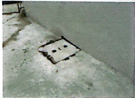
Foto 8: Fabricación de caja de registro para drenaje de cocina.
