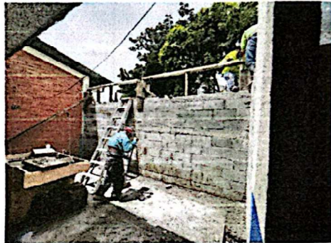
Foto 8: Armado y encofrado para dintel de ventana.
