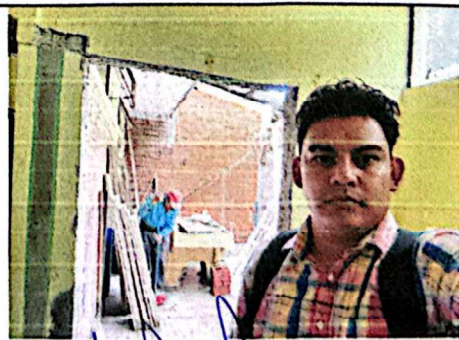
Foto 12: Fotografía en el establecimiento durante los procesos constructivos.
