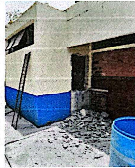
Foto 2: Apertura de vano para puerta.
