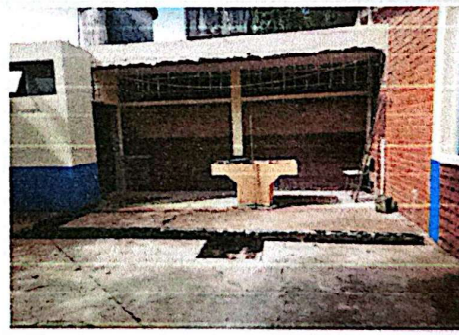
Foto 4: Zanqueo y traslado de tuberías de agua potable y drenajes.
