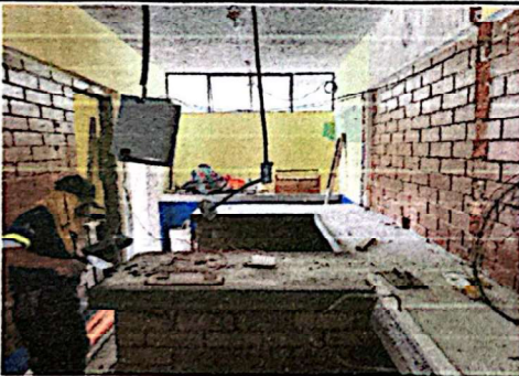
Foto 9: Preparación de mesas de trabajo para colocación de azulejo.
