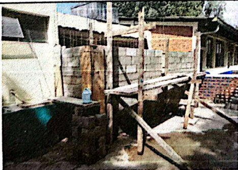
Foto 5: Levantado de muro de block.
