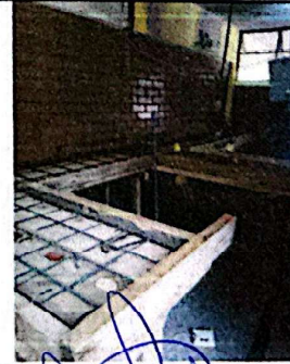
Foto 6: Armado y encofrado para mesas de trabajo.
