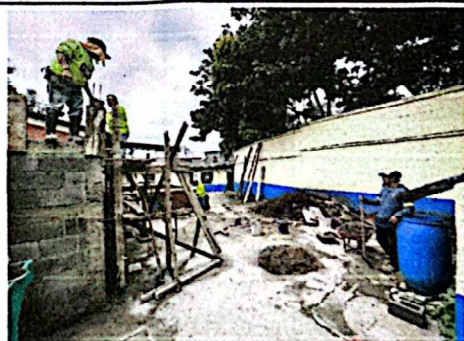
Foto 10: Trabajos de fundición de columnas.
