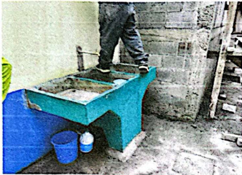
Foto 7: Suministro e instalación de pila.
