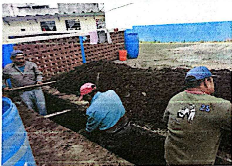
Foto 3: Proceso de zanqueo para levantado de muro.
