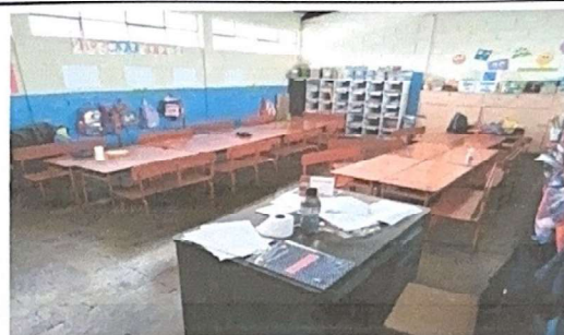
Foto 8: instalacion de piso aula 5
