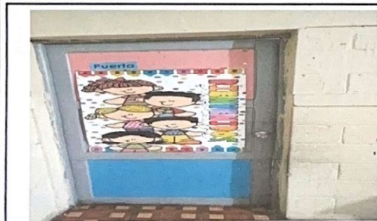
Foto 5: instalacion de puerta aula 4
