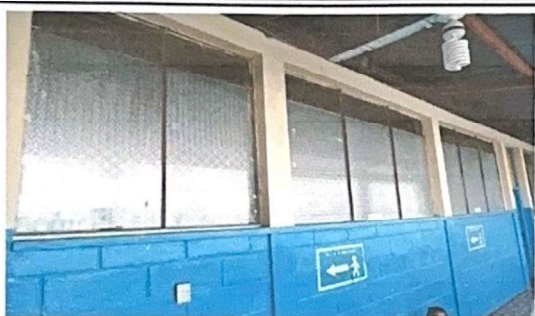
Foto7: instalacion de ventanas aula 5
