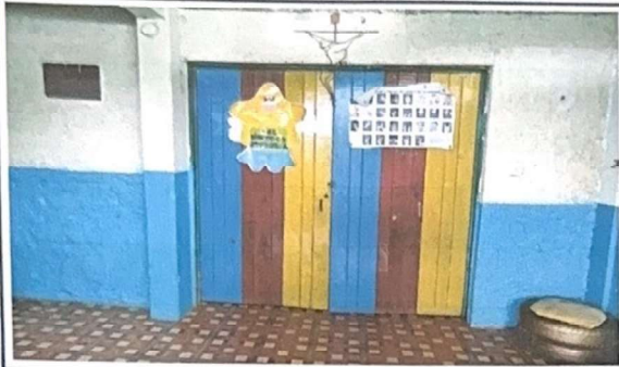
Foto 1: instalacion de. Porton
