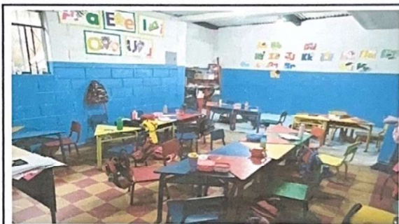
Foto 4: instalacion de piso aula 3
