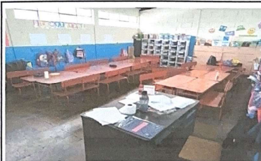
Foto 10: cambio de piso de aula 6
