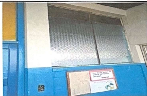
Foto 9: cambio de ventanas de aula aula 6
