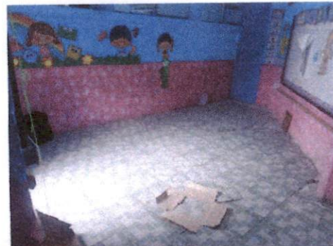
AULA CON PISO COLOCADO TERMINADA
