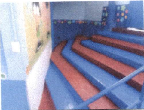
REMOZAMIENTO DE GRADAS TERMINADO
