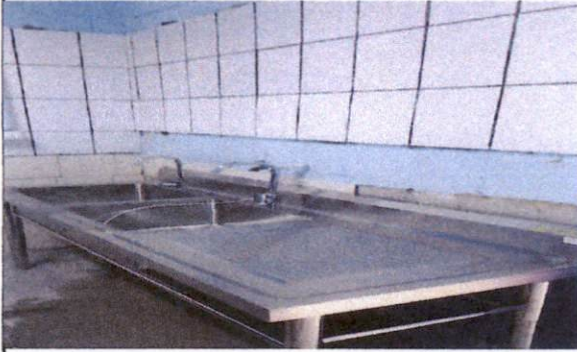
CAMBIO DE PILA A LAVAPLATOS ACERO
