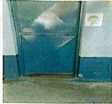
Foto 2: mantenimiento de 18 puertas en pintura
