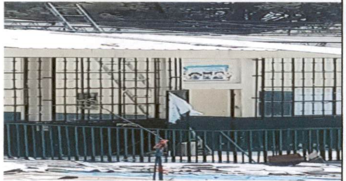
Foto 2: Instalación de tubo de 2x1 para atornillar lamina galvanizada
