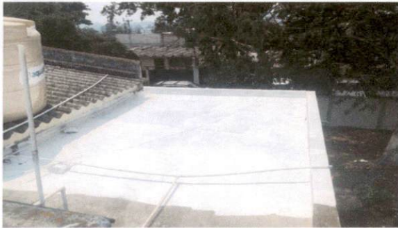
Foto 5: Impermeabilización de terraza de cocina.
