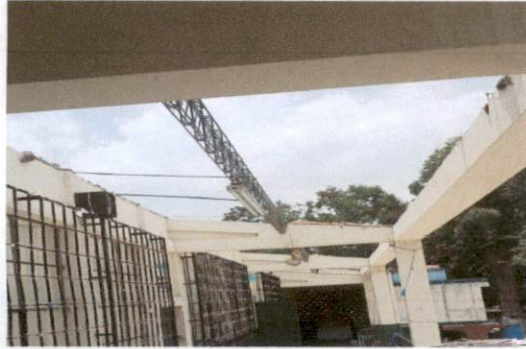
Foto1: Retiro de teho de lamina duralita
