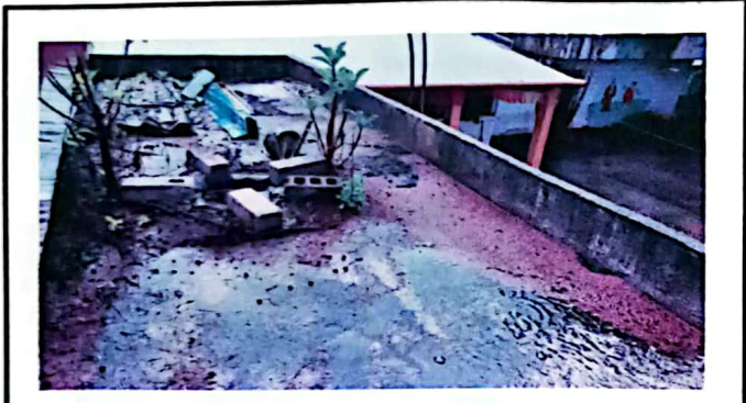
Foto 3: REMODELACION DE TECHO DEL PASILLO DE ENTRADA
