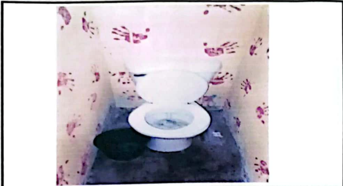
Foto 1: SUSTITUCION DE BAÑOS
