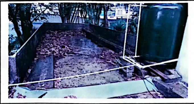
Foto 6: REMODELACION DE TECHO DE COCINA
