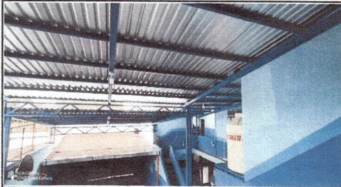
Foto 1: Se da por finalizada la sustitución del techo antos en el patio primario como secundario.
