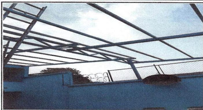
Foto 1: Se realiza la estructura de metal para sustituir el techo.
