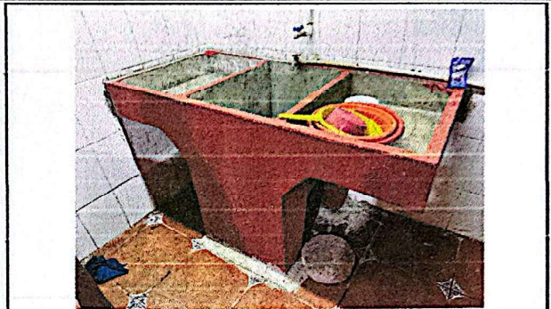
Foto 8: Suministro e instalación de pila nueva.
