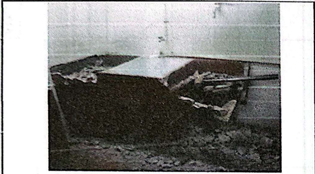
Foto 7: Demolición de pila existente.
