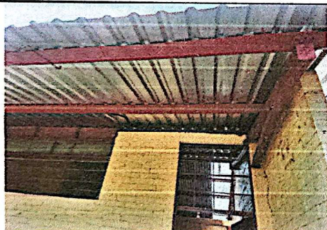
Foto 3: Se realizó la instalación de la lámina troquelada y el mantenimiento a la estructura.
