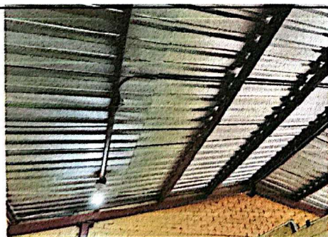
Foto 5: Laminá troquelada calibre 26 debidamente instalada, se verifica que cada lamina cuente con el anclaje de manera apropiada.
