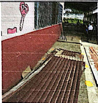
Foto 1: Se desmonta el techo en malas condiciones.
