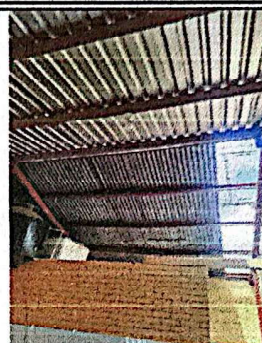
Foto 2: Se retiran las láminas en malas condiciones y se realizará el mantenimiento a la estructura de techo.
