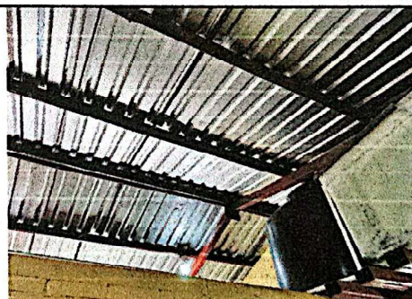
Foto 4: Suministro e instalación de lámina en techo + lijado y pintura de la estructura de soporte para el techo.
