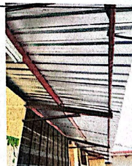
Foto 6: Techo en voladizo, ubicado en el pasillo del área de cocina.
