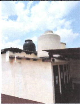
Foto 9: Los tinacos, que no cuentan con buen abastecimiento de agua y se deberá sustituir la línea de abastecimiento desde el cisterna y la bomba.
