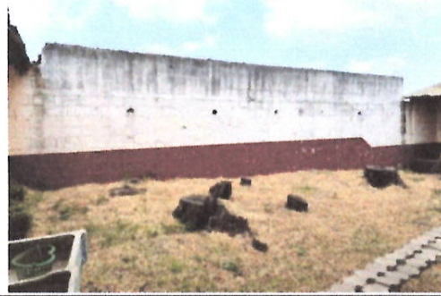
Foto 10: Es necesario colocar 3 hiladas de block, para evitar problemas de invasión por los usuarios de la cancha de futbol.
