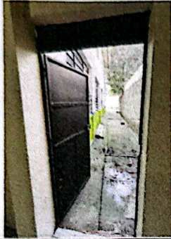
Foto 7: Mantenimiento de puerta incluye lijado y pintura.
