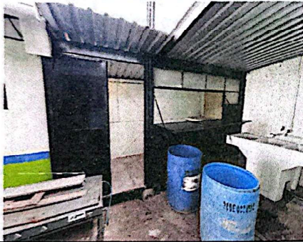
Foto 9: Mantenimiento de estructura metálica en cocina.
