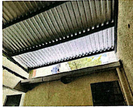
Foto 8: Suministro e instalación de techo en patio.
