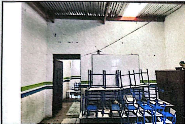
Foto 1: . Se muestra el muro que se deberá demoler para ampliar el espacio del salón para los niños.
