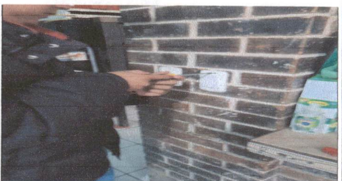
CAMBIO DE TOMACORRIENTES
