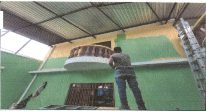
PINTURA EN PAREDES EN PATIO DE ESTABLECIMIENTO
