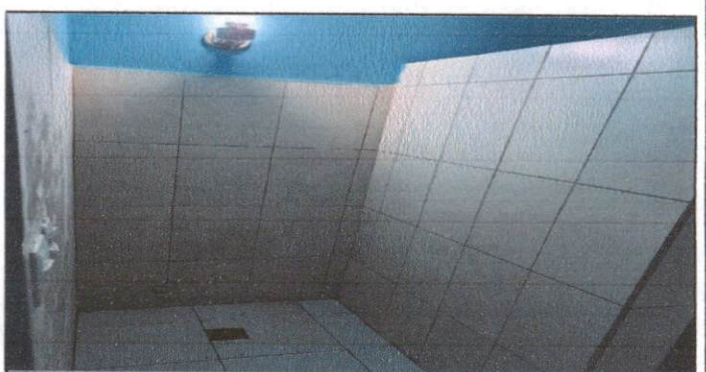
INSTALACION DE PISO EN AREA DE BAÑO
