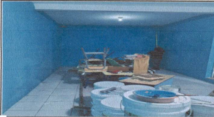
PLICACIÓN DE PINTURA EN AULAS
