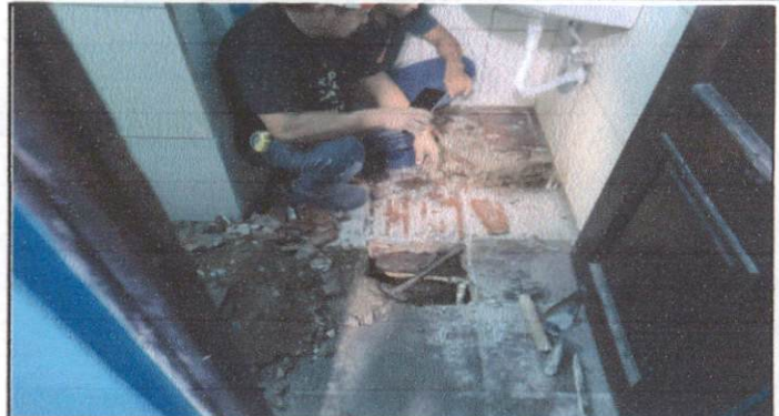
BUSQUEDA DE FUGAS SUBTERRANEAS
