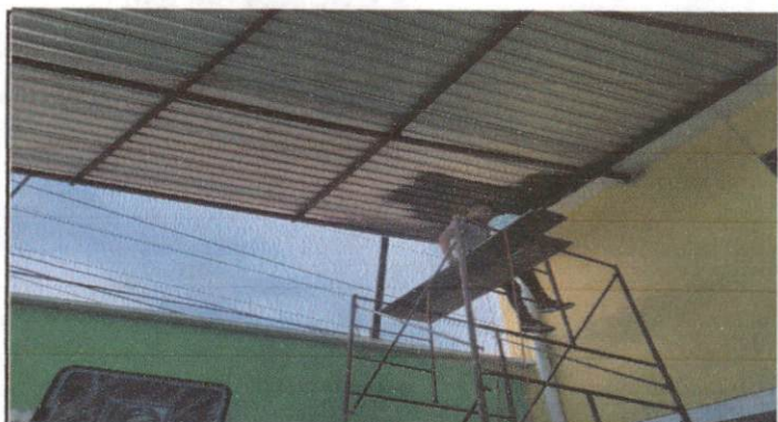
APLICACIÓN DE PINTURA ANTICORROSIVA EN TECHO DE PATIO
