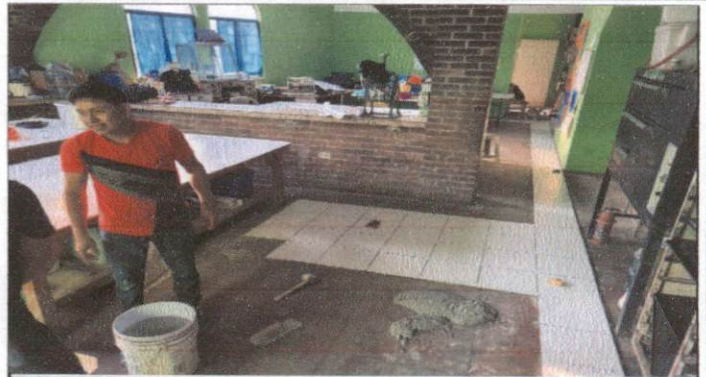
APLICACION DE PISO EN AREA DE COCINA
