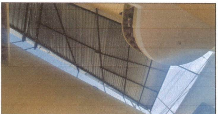
Techo de Patio
