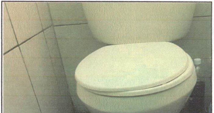
Baño a Reparar
