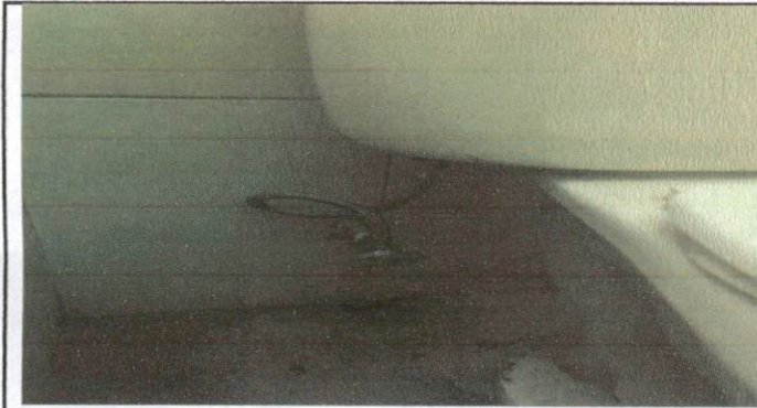
Baño a Reparar
