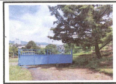
Foto 3: PORTÓN NUEVO YA INSTALADO Y PINTADO EN EL ÁREA DE PARQUEO.
