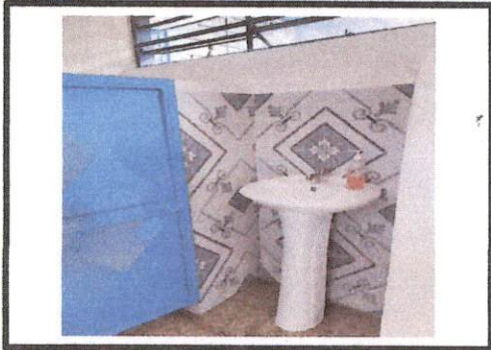
Foto1: CAMBIO DE LAVAMANOS DEL BAÑO DE NIÑOS DEL MÓDULO "B" DE LA PLANTA BAJA Y PINTURA DE LAS PUERTAS.
