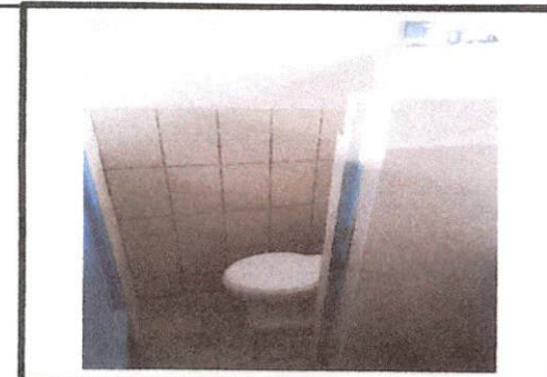
Foto 6: CAMBIO DE AZULEJO DE LAS PAREDES DEL BAÑO DE NIÑAS DEL MÓDULO "A" PLANTA BAJA.
