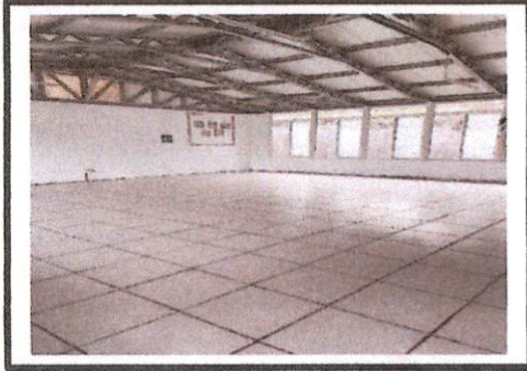
Foto 1: FUNDICIÓN DE TODA EL ÁREA DEL PISO DE LA CLASE PREFABRICADA.
