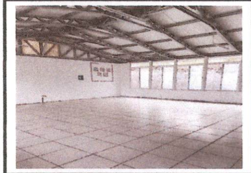
Foto 2: COLOCACIÓN DE PISO CERÁMICO EN EL AULA PREFABRICADA.
