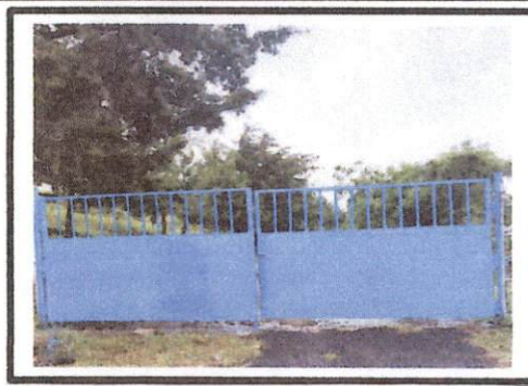
Foto 2: PORTÓN NUEVO YA INSTALADO Y PINTADO EN EL ÁREA DE PARQUEO.
