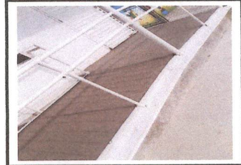
Foto 4: RAMPA TERMINADA Y MANTENIMIENTO DE PASAMANOS.
