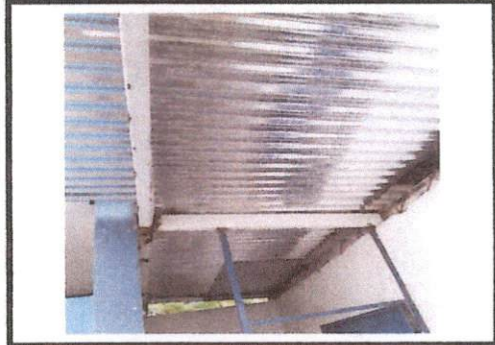
Foto 4: CAMBIO DE LÁMINAS NUEVAS A LA BODEGA.
