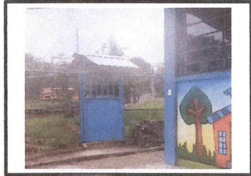
Foto 2: PUERTA FORMAL NUEVA CON TECHITO Y CAMBIO DE CHAPA.
