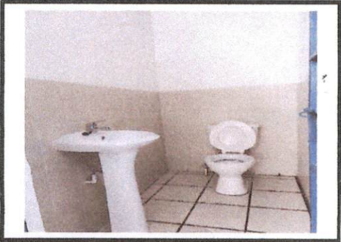
Foto1: BAÑO TERMINADO DEL MÓDULO "C".
