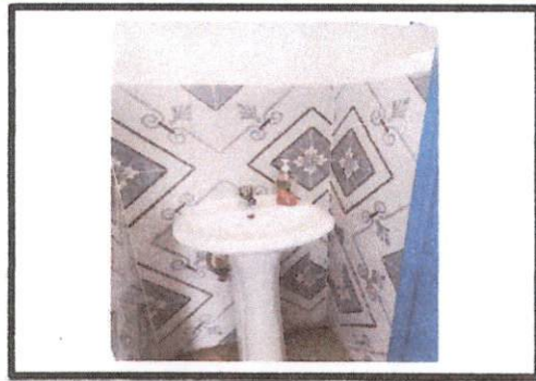
Foto 2: CAMBIO DE LAVAMANOS DEL BAÑO DE NIÑAS DEL MÓDULO "B" DE LA PLANTA BAJA Y PINTURA DE LAS PUERTAS.
