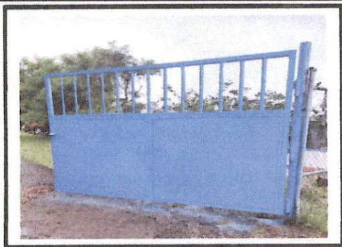
Foto 1: PORTÓN NUEVO YA INSTALADO Y PINTADO EN EL ÁREA DE PARQUEO.
