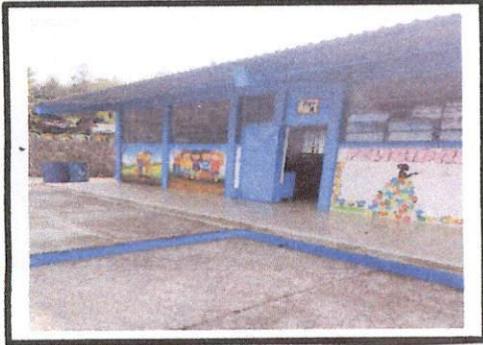
Foto 3: BORDILLOS TERMINADOS EN LOS MÓDULOS DE LA PLANTA BAJA.
