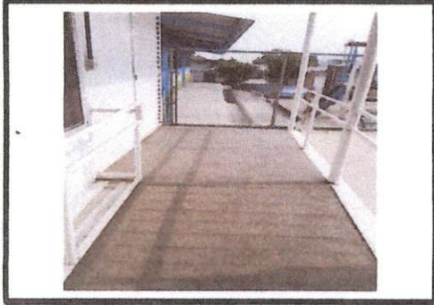
Foto 3: FUNDICIÓN DE RAMPA.
