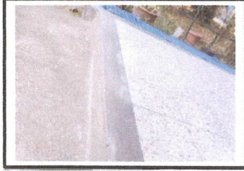
Foto 2: REALIZACIÓN DEL NUEVO BORDILLO EN EL MÓDULO "B".
