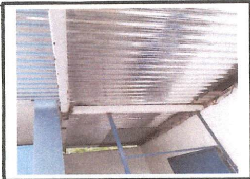
Foto 5: CAMBIO DE TECHO PARA EL BAÑO DEL MÓDULO "C".
