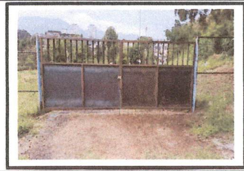
Foto 6: PORTÓN INSTALADO SIN PINTURA.
