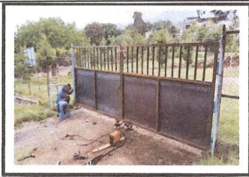
Foto 5: INSTALACIÓN DEL NUEVO PORTÓN FORMAL.
