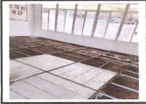
Foto 1: DESMONTAJE DE DUELAS EN EL AULA PREFABRICADA.
