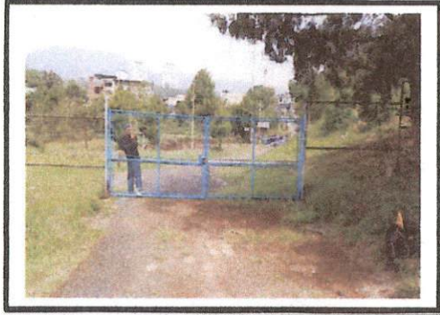
Foto1: DESMONTAJE DEL PORTÓN DE MALLA ANTIGUO.
