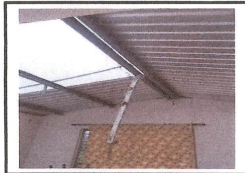
Foto 2: DESMONTAJE DEL TECHO DURALITA DEL ÁREA DE LA CLÍNICA.
