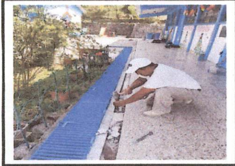
Foto 1: DESMONTAJE DE BORDILLOS EN MAL ESTADO Y QUEBRADOS DE LOS PASILLOS DE LOS MÓDULOS "A Y B" DEL PRIMER MÓDULO.
