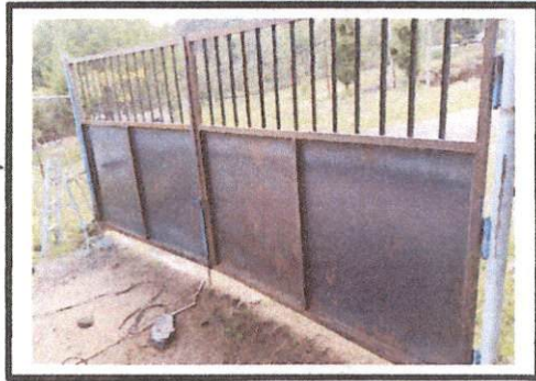
Foto 3: INSTALACIÓN DEL NUEVO PORTÓN FORMAL.
