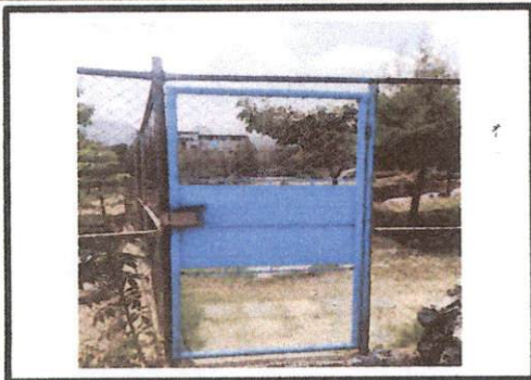
Foto1: CAMBIO DE PUERTA PEQUEÑA DE MALLA Y DE CHAPA.
