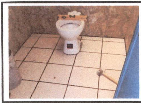
Foto 2: CAMBIO DE PISO CERÁMICO Y CAMBIO DE INODORO EN UNO DE LOS BAÑOS DEL MÓDULO "C".
