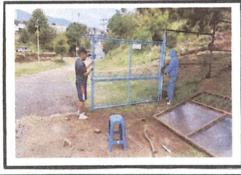
Foto 2: DESMONTAJE DEL PORTÓN DE MALLA ANTIGUO.
