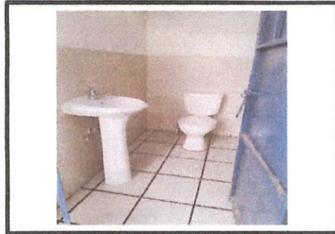
Foto 4: COLOCACIÓN DEL SANITARIO Y LAVAMANOS EN EL BAÑO DEL MÓDULO "C".
