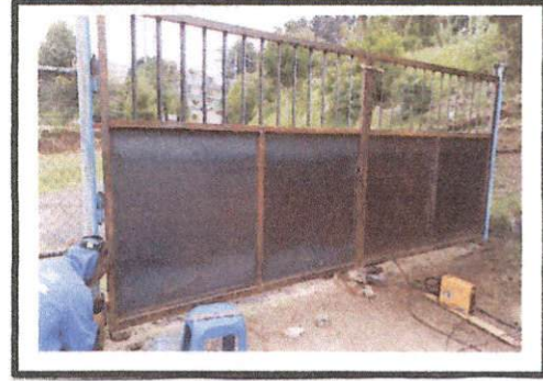
Foto 4: INSTALACIÓN DEL NUEVO PORTÓN FORMAL.
