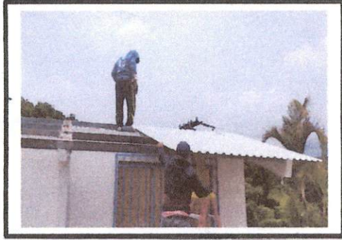
Foto 3: MONTAJE DEL NUEVO TECHO EN EL ÁREA DE LA CLÍNICA.
