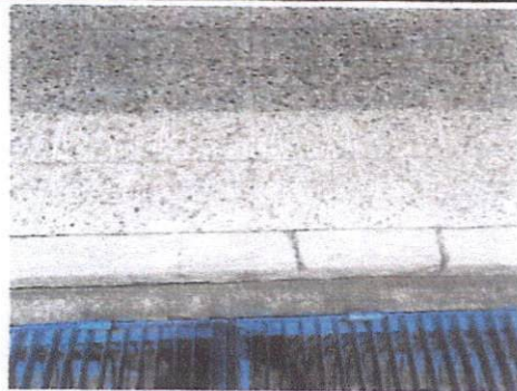
Foto 17: Reparación de bordillos quebrados y astillados de la primera parte del Módulo B - Planta Baja.
