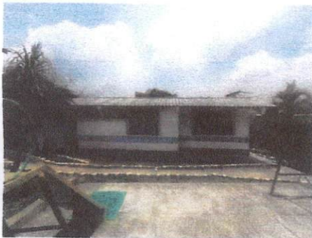
Foto 9: Clínica dental: Se llevará a cabo el desmontaje del techo duralita y se llevará a cabo el mantenimiento de costaneras.
