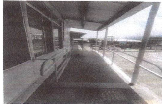
Foto 4: Levantamiento de duelas de la rampa de entrada al aula y nueva fundición de rampa.
