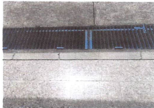
Foto 16: Reparación de bordillos quebrados y astillados del Módulo A - Planta Baja.
