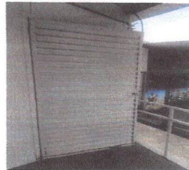
Foto 6: Cambio de puerta por presentar óxido y picaduras.
