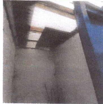
Foto 20: Tendrá cambio de techo, se pintarán las paredes y se colocará azulejo.
