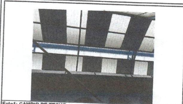
Foto 1: CAMBIO DE TECHO
