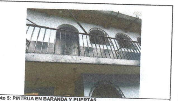
Foto 5: PINTRUA EN BARANDA Y PUERTAS
