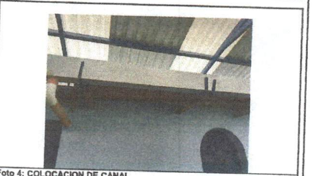
Foto 4: COLOCACION DE CANAL
