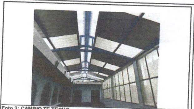
Foto 2: CAMBIO TE TECHO
