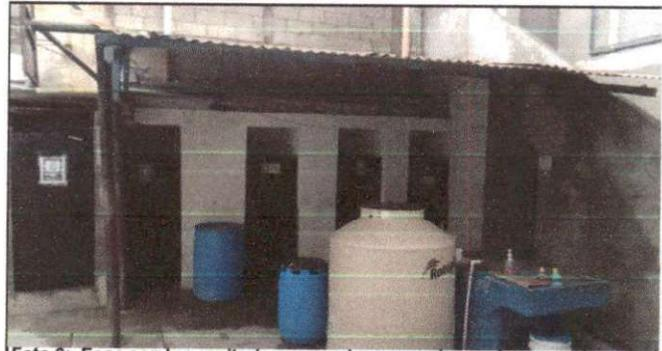
Foto 6: Esos son los sanitarios que se les va a colocar piso caramico, el sanitario ubicado a la derecha sera cambiado por uno nuevo, y el primero a mano izquierda se le colocará lavamanos.
