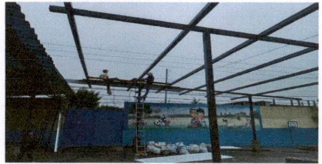
Foto 2: Montaje de laminado nuevo
