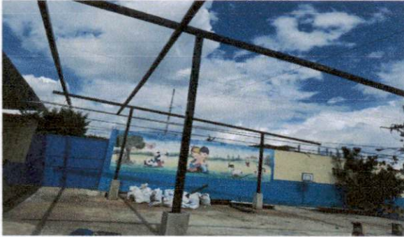
Foto 1; Montaje de costaneeras nuevas.
