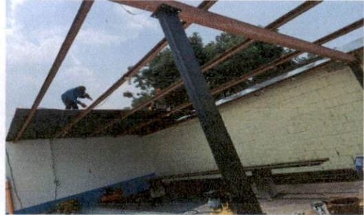
Foto 2: Desmontado de lamina anterior
