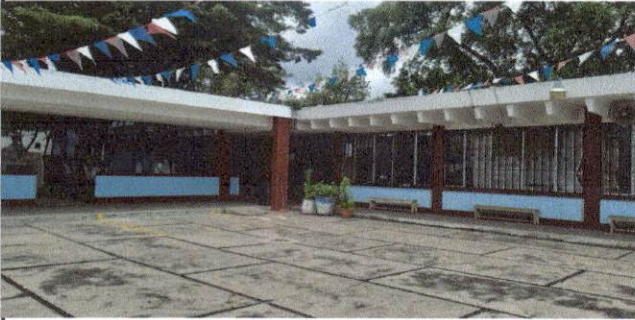
Foto1: Pintura de área administrativa.
