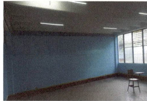
Foto 4: Pintura interior y sistema eléctrico.
