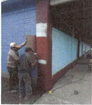
Foto1: Pintura de columnas del segundo pabellón.
