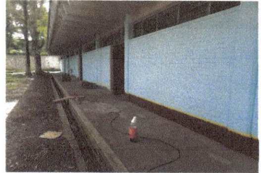
Foto 2: Pintura exterior segundo pabellón.
