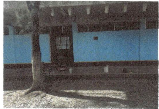
Foto 4: Pintura de zocalo exterior de segundo pabellón.
