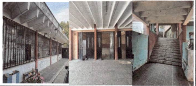
Foto 2 Pintura de parte Exterior de Salon de usos Multiples
