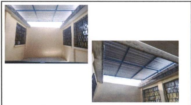
Foto 2: Áreas techadas con lámina y estructura nueva.
