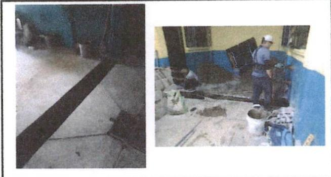
Foto 2: Zanja para la correcta cimentación de la pared de ampliación de sala de maestros
