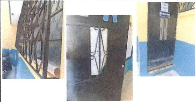
Foto 4: Mantenimiento de balcones, puertas, chapas y ventanas. Debido al tiempo, ya se encuentra con partes oxidadas y deterioradas.
