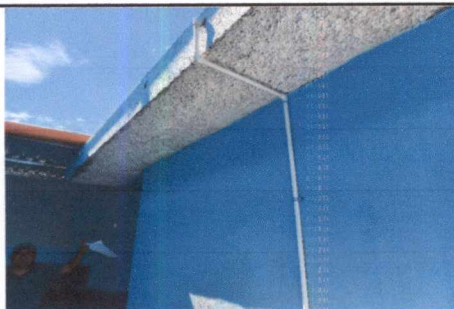
FOTO 11: INSTALACIÓN DE TUBERÍA PVC DE AGUA POTABLE
