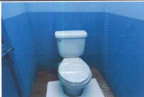
FOTO 7: SUSTITUCIÓN DE INODOROS
