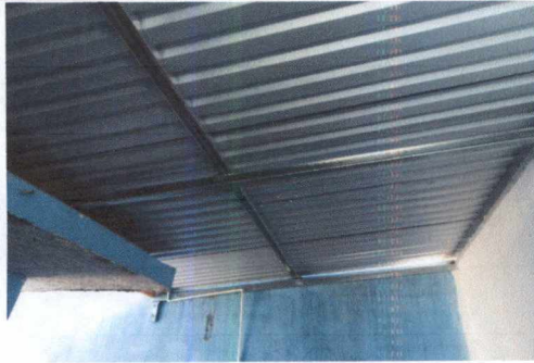
FOTO 13: INSTALACIÓN DE ESTRUCTURA DE SOPORTE DE METAL Y LÁMINA TROQUELADA
