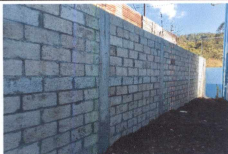
FOTO 9: REPARACIÓN DE MURO PERIMETRAL
