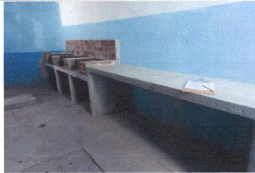
FOTO 14: ESTRUFA RURAL Y ENCIMERA DE CONCRETO
