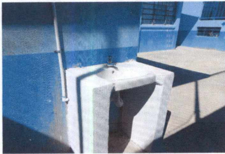
FOTO 15: SUSTITUCIÓN DE LAVAMANOS
