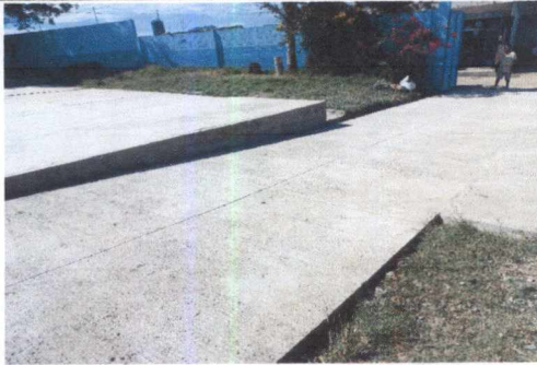
FOTO 1: SUSTITUCIÓN DE PISO DE CONCRETO
