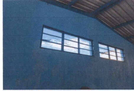
FOTO 4: SUSTITUCIÓN DE VENTANAS DE METAL
