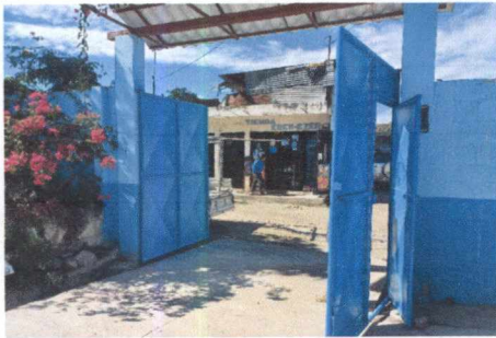
FOTO 3: MANTENIMIENTO DE PORTÓN DE METAL
