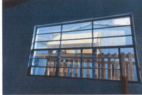
FOTO 2: SUSTITUCIÓN DE VENTANAS DE METAL
