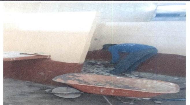
Foto 2: CAMBIO DE MINGITORIO DE CONCRETO EN MAL ESTADO
