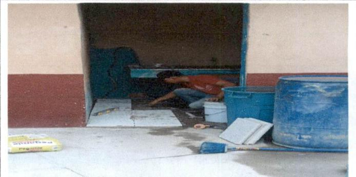
Foto 6: INSTALACIÓN DE PISO GRANITO EN ÁREA DE LA PILA
