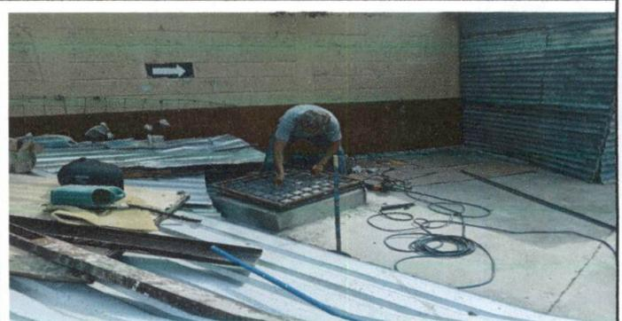
Foto 4: FABRICACIÓN E INSTALACIÓN DE TAPADERA DE CISTERNA
