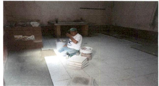
Foto 4: EVANTADO DE AZULEJO Y TORTA, INSTALACIÓN DE PISO GRANITO
