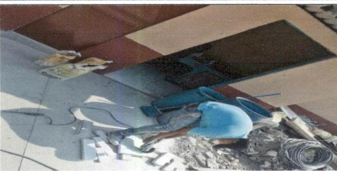
Foto 5: INSTALACIÓN DE PISO GRANITO EN ÁREA DE LA PILA
