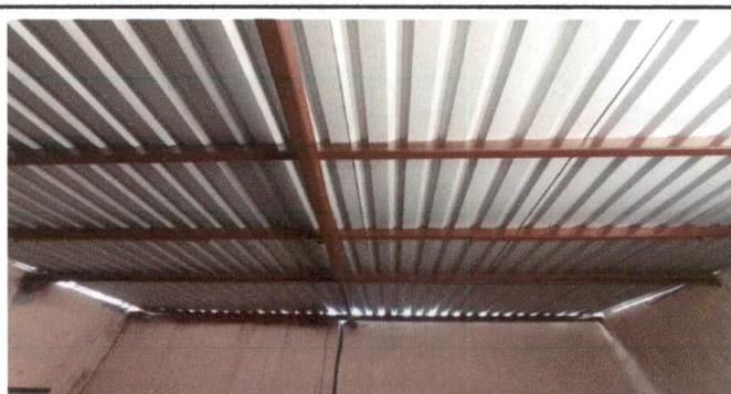
Foto 6: INSTALACIÓN DE LÁMINAS EN EL TECHO DE LA COCINA
