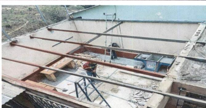
Foto 4: MANTENIMIENTO DE COSTANERAS: LIJADO Y PINTADO
