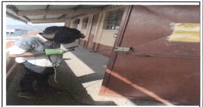
Foto 4: MANTENIMIENTO DE PORTÓN, PUERTA SEGUNDO NIVEL CON CHAPA YALE : LIJADO, CEPILLADO Y PINTADO
