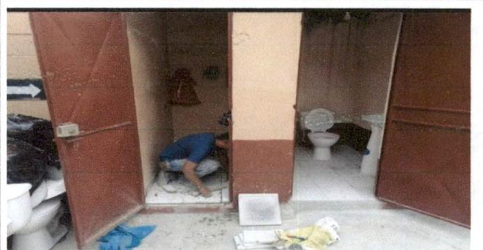
Foto 4: INSTALACIÓN DE PISO GRANITO EN BAÑO DE MAESTRAS
