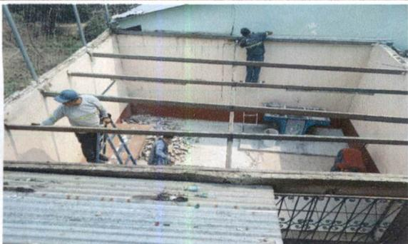
Foto 3: MANTENIMIENTO DE COSTANERAS, LIJADO Y PINTURA
