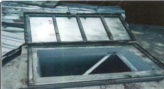
Foto 3: FABRICACIÓN E INSTALACIÓN DE TAPADERA DE CISTERNA
