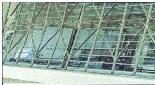
Foto 18: Mantenimiento de un balcón en la clase de segundo primaria con medida de 6 metros cuadrados y un balcón en la bodega vespertina con cuatro metros cuadrados en la planta baja. Lijado, cepillado, aplicación de pintura anticorrosiva, soldar piezas de adorno sueltas.
