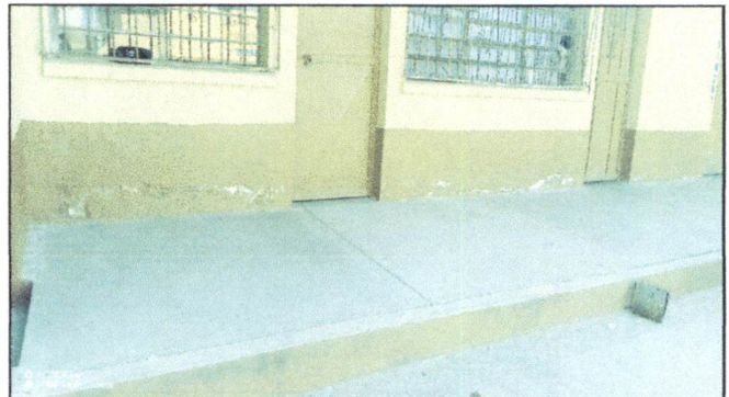
Foto 28: pintar el sócalo en baños de niños, niñas, baño de preparatoria, cocina y en muro perimetral con pintura impermeabilizante.
