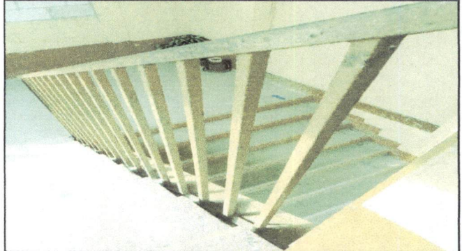
Foto 44: Mantenimiento de barandas de metal. Lijado, pintado con pintura anticorrosiva, cambio de tubo picado, sujetar bien las barandas que estan a los lados de las gradas (estan lado derecho e izquierdo).
