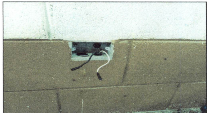
Foto 58: Cambio y compra de 4 tomacorrientes, uno en el pasillo principal y uno en las clases de preparatoria, uno en los salones de tercero y primero primaria.
