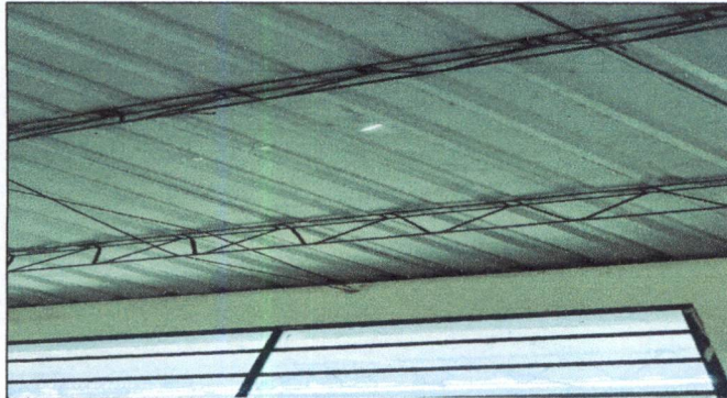
Foto 7: Sustitución y compra de 4 láminas de 10 pies calibre 26 troquelada Aluzic, una en techo del pasillo de gradas segundo nivel, una en pasillo del segundo nivel, frente al aula de quinto primaria, una por dentro de las
