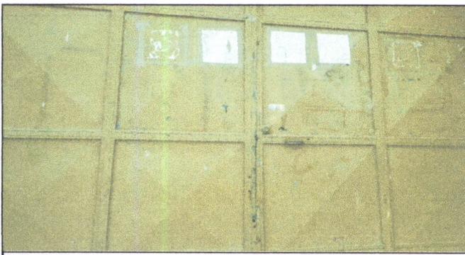
Foto 47: Mantenimiento de portón de metal de cuatro puertas de la calle principal (lijado, cepillado y pintado con pintura anticorrosiva de los dos laterales) y cambio de chapa Yale.
