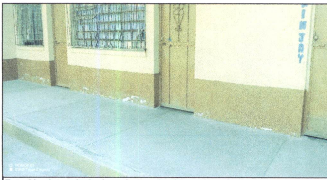
Foto 29: pintar el sócalo en baños de niños, niñas, baño de preparatoria, cocina y en muro perimetral con pintura impermeabilizante.
