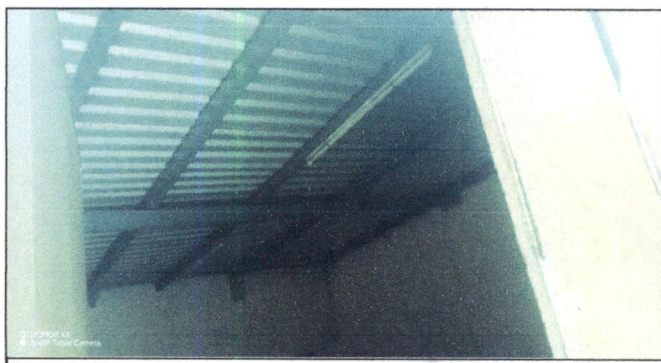
Foto 11: Mantenimiento de costaneras incluyendo lijado, aplicación de anticorrosivo y pintado en el techo de cocina.
