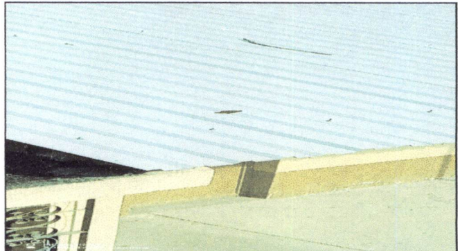
Foto 8: Sustitución y compra de lámina de 12 pies calibre 26 troquelada aluzic, en el techo de bodega de la jornada vespertina por mal estado.
