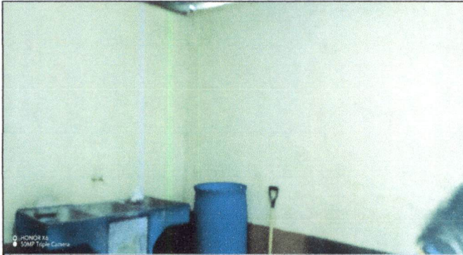
Foto 25: Pintar las paredes interiores y exteriores con pintura impermeabilizante en cocina.
