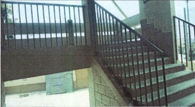
Foto 43: Mantenimiento de barandas de metal. Lijado, pintado con pintura anticorrosiva, cambio de tubo picado, sujetar bien las barandas que estan a los lados de las gradas (estan lado derecho e izquierdo).
