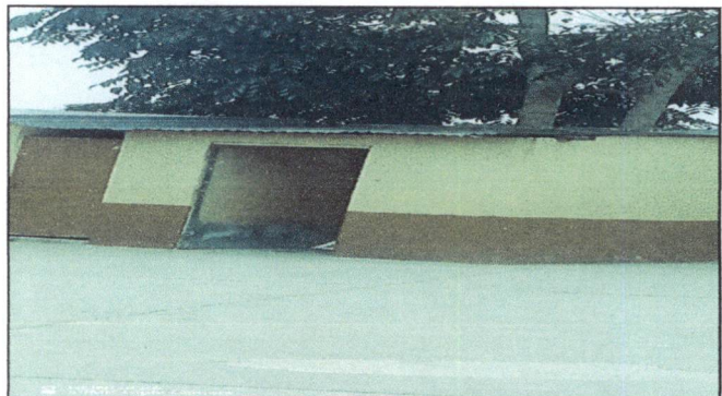
Foto 10: Desmontar, comprar y colocar 4 láminas de 8 pies calibre 26 troquelada Aluzic en baño de preparatoria y pila.
