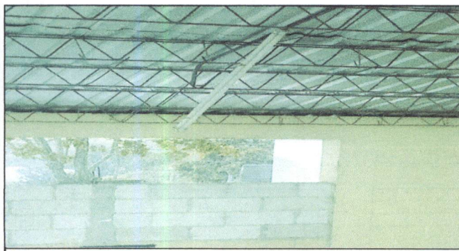
Foto 53: Se cambian lámparas tipo led en el pasillo en frente, 4 lámparas led pasillo de gradas segundo nivel 1 lampara, pasillo del segundo nivel 3 lámparas) y limpieza de base y colocación de tres balastos.
