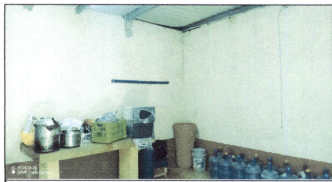
Foto 24: Pintar las paredes interiores y exteriores con pintura impermeabilizante en cocina.
