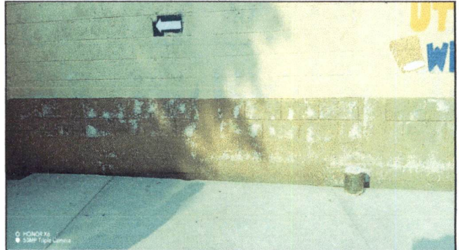
Foto 26: pintar el sócalo en baños de niños, niñas, baño de preparatoria, cocina y en muro perimetral con pintura impermeabilizante.
