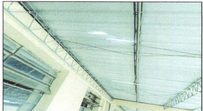
Foto 4: Sustitución y compra de 4 láminas de 10 pies calibre 26 troquelada Aluzinc, una en techo del pasillo de gradas segundo nivel, una en pasillo del segundo nivel, frente al aula de quinto primaria, una por
