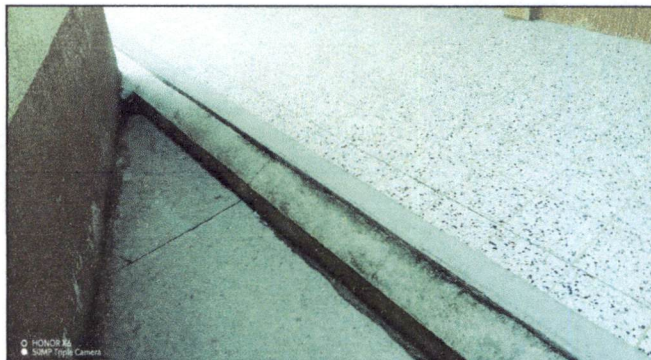
Foto 52: Reparación de plancha de concreto de patio al lado de la cocina dejando un desnivel para que no se acumule el agua y quitar cimiento de concreto de un tubo de agua de canales que no deja fluir de agua.
