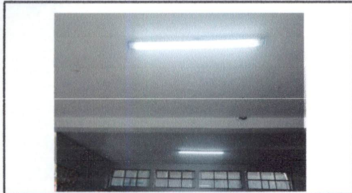
Foto 3: SUSTITUCION DE LAMPARAS CONTRA POLVO.
