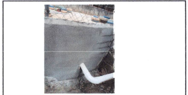
FOTO 2 REPARACION DE MURO PERIMETRAL
