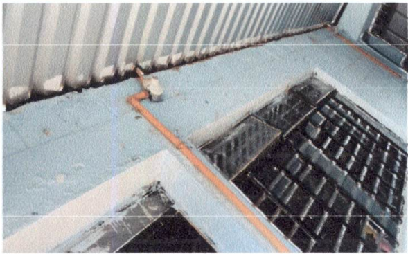
Foto 15: 17.4 Sustitución de focos ahorradores
