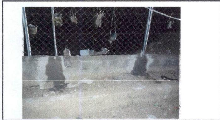
Foto1: REPARACION DE MURO PERIMETRAL CON TUBO GALVANIZADO Y MAYA GALVANIZADA
