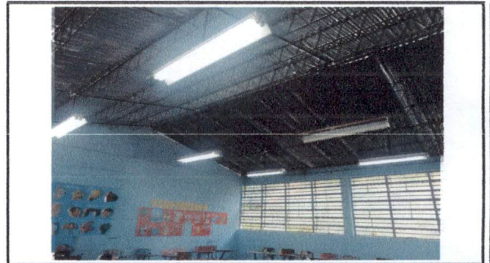
Foto 4: SUSTITUCION DE LÁMPARAS CONTRA POLVO.
