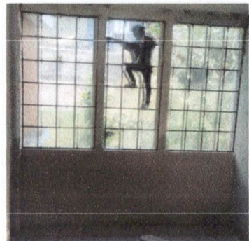
Foto SUSTITUCION DE VIDRIOS DE VENTANAS DE TODAS LA AULAS, Y CORREDORES
