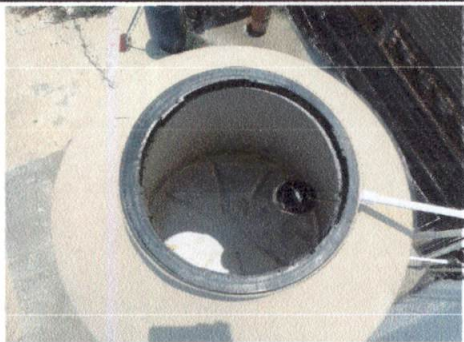
Foto REPARACION Y MANTENIMIENTO DE CISTERNAS
