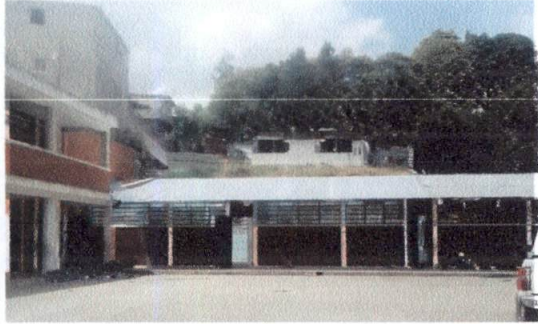
Foto1.1 SUSTITUCION DE LÁMINA POR LAMINA TROQUELADA
