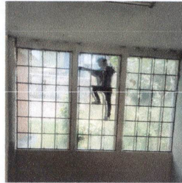
Foto 1 Sustitución de vidrios de ventanas.
