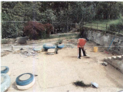
Foto 1 Reparación de muro perimetral.
