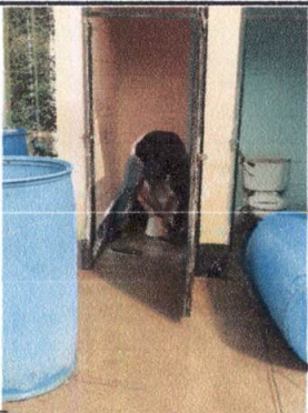
Foto 1 Sustitución sanitarios y accesorios.
