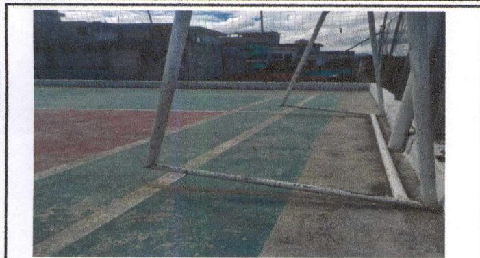
Foto 1: Anclaje de portería.
