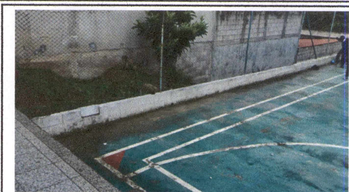
Foto 2: Continuacion de muro con 3 hiladas de blocc mas malla.
