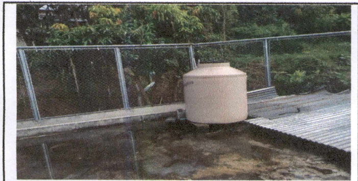
Foto 5: Sustitucion tuberia pvc linea principal de tinaco a cocina
