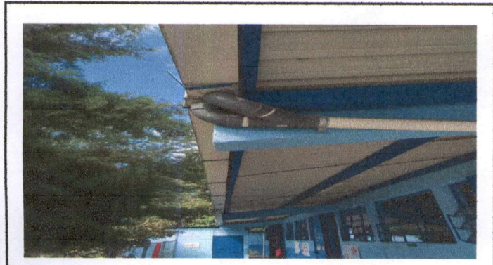
Foto 3: Reparacion de canales.
