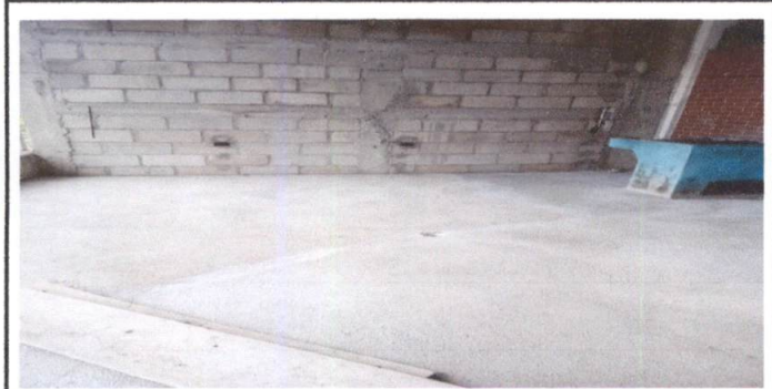
Foto 5: PISO DE CONCRETO
