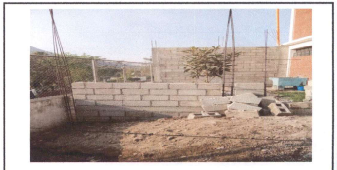
Foto 6: AMPLIACION PARED COCINA
