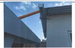
FOTO 3: INSTALACIÓN DE CANAL DE METAL EN CUBIERTA DE AULA
