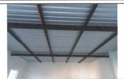
FOTO 4: INSTALACIÓN DE ESTRUCTURA PORTANTE Y CUBIERTA DE LÁMINA EN AULA
