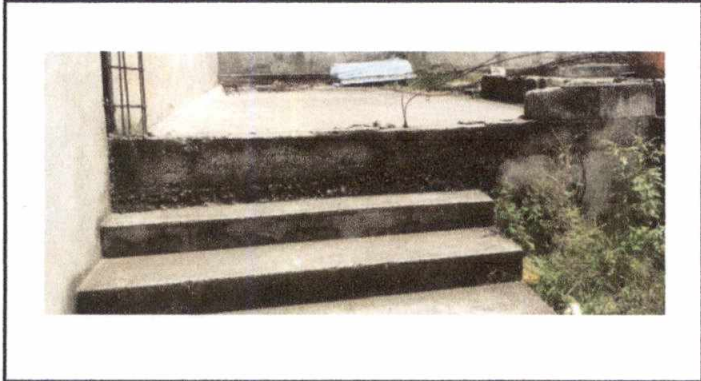
Foto1: Mejoramiento de muro existente de aula
