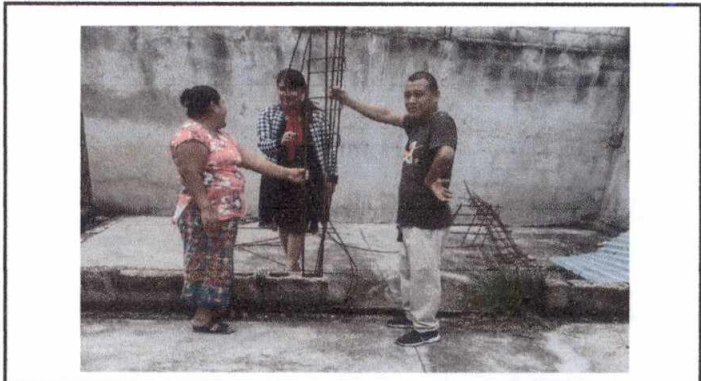
Foto 4: Mejoramiento de muro y continuación de columnas existentes
