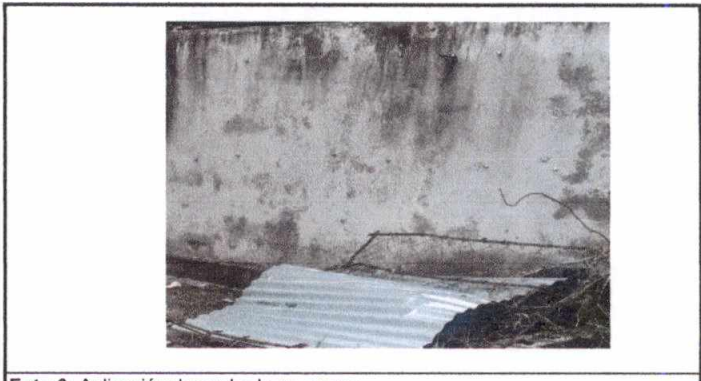
Foto 6: Aplicación de acabado en muros
