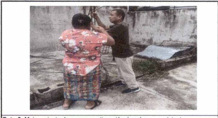
Foto 5: Mejoramiento de muro y continuación de columnas existentes
