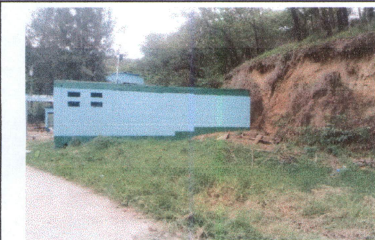
Foto 11: VISTA DE PARTE DE LA ENTRADA DE LA ESCUELA
