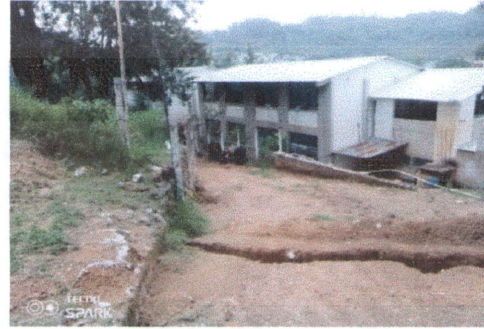
Foto 8: PREPARACION DEL CAMINO PARA LA HECHA DE LA CUNETETA
