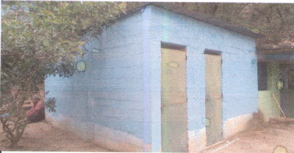
Foto 5: PINTADO DE SANITARIOS EN LA PLANTA BAJA EN PROCESO
