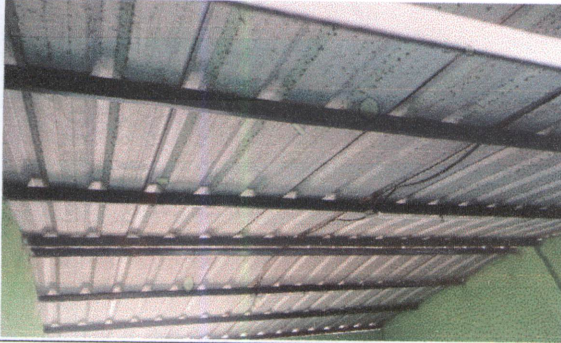
TECHO DE AULAS DEL 2DO NIVEL AUN NO SE A CAMBIADO
