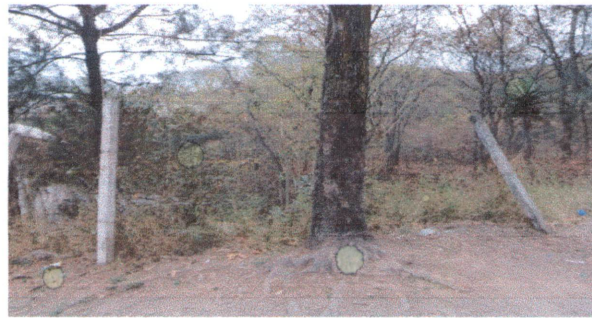
Foto 12: SE TIENE CONTEMPLADO CAMBIAR ESOS PARALES DE CONCRETO PARA COLOCAR BIEN LA MALLA
