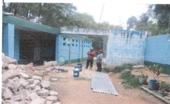
Foto 6: PARTE DE ADENTRO EN PROCESO DE PINTADO
