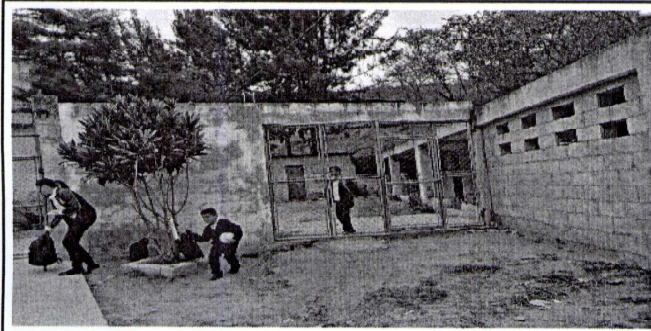
Foto 9: Pintura paredes exteriores
