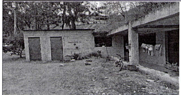
Foto 8: Pintura paredes exteriores
