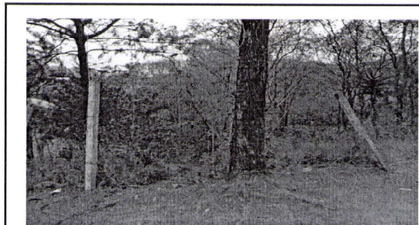
Foto 12: Colocación de postes y malla
