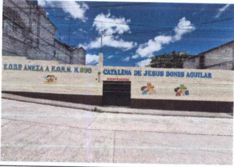
Foto 13: Pintura de muros exteriores
