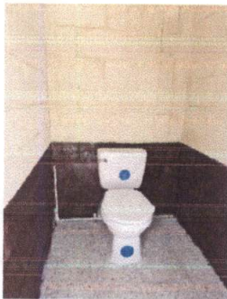
Foto 9: Sustitución de sanitario nuevo y abastecimiento de agua para los 3 sanitarios.
