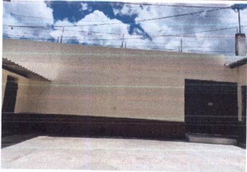
Foto 15: Pintura de muros exteriores, mantenimien de porton.
