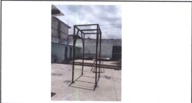
Foto 3: PREPARACION DE ESTRUCTURA DE METAL PARA CARGAR EL TINACO
