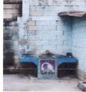
Foto 4: BASE PARA TINACO - Su instalación debe ser sobre la pila de color celeste.
