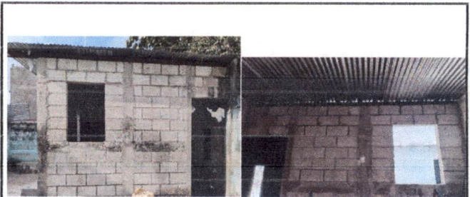
Foto 6: VENTANAS SALÓN 3 - (Ángulo norte y sur de la escuela)
