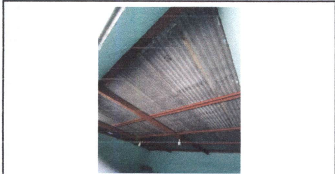
Foto 1: TECHO (ESTRUCTURA Y LAMINA) SALON 1 - (Vista desde ángulo norte del salón)
