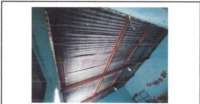
Foto 3: TECHO (ESTRUCTURA Y LAMINA) SALON 2 - (Vista desde ángulo norte del salón)
