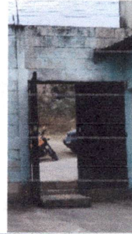
Foto 2: PORTÓN PRINCIPAL DE LA ESCUELA - (Vista desde ángulo sur)
