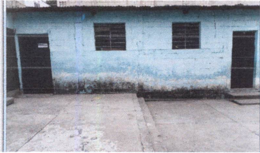
Foto 1: PUERTAS SALÓN 1 - (Ángulo este de la escuela)
