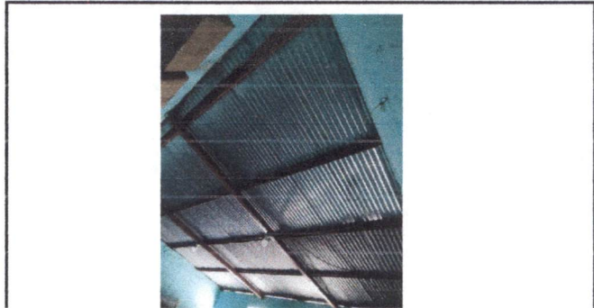
Foto 2: TECHO (ESTRUCTURA Y LAMINA) SALON 1 - (Vista desde ángulo sur del salón)
