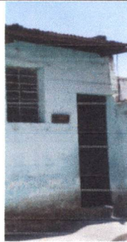
Foto 3: PUERTA SALÓN 2 - (Ángulo este de la escuela)
