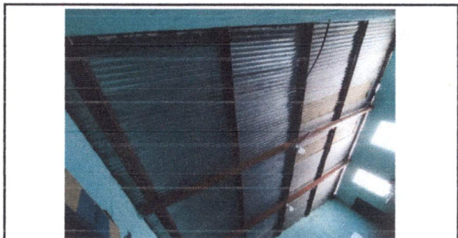
Foto 4: TECHO (ESTRUCTURA Y LÁMINA) SALON 2 - (Vista desde ángulo sur del salón)
