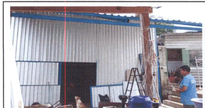
**Finalizacion de estructura, colocacion de cubierta y techo con laminas troqueladas**
