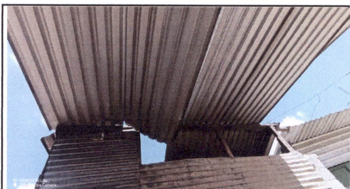
Foto 4: TECHO DE LAMINA
