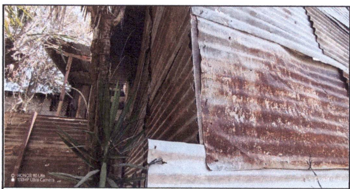
CUBIERTA DE LAMINA ACANALADO
