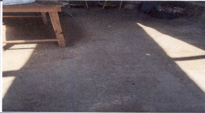
PISO DE PATIO
