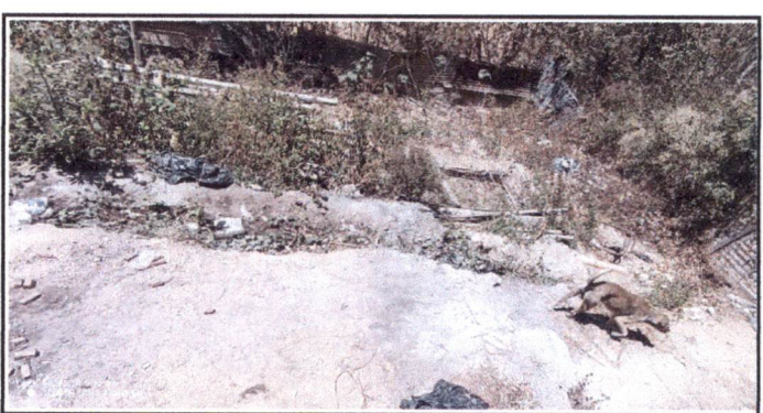
EXTERIOR DE COCINA NORTE
