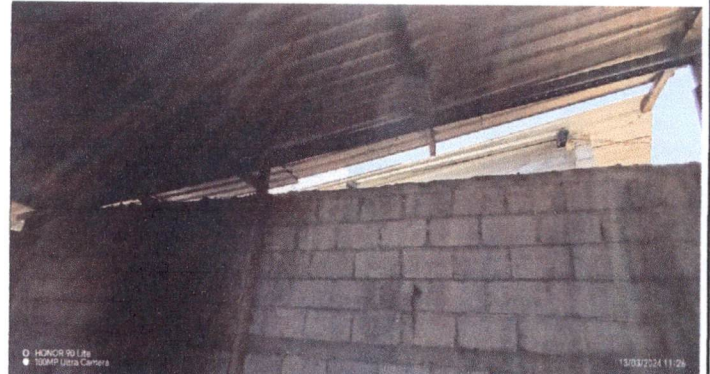
MURO A REPELLAR Y LIMPIAR 32 M2
