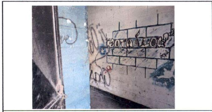
Foto 6: paredes de sanitarios deterioradas se pretende colocar azulejo y cernido sobre ello.
