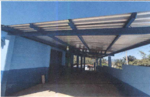
FOTO 3: SUSTITUCIÓN DE CUBIERTA DE LÁMINA Y MANTENIMIENTO DE ESTRUCTURA
