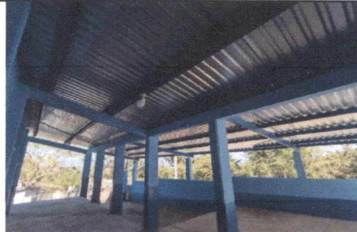
FOTO 4: REPARACIÓN DE SISTEMA ELÉCTRICO
