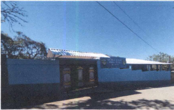
FOTO 1: SUSTITUCIÓN DE PORTÓN DE METAL
